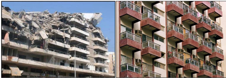
تصویر (۴): پرهیز از تراس‌ها و بالکن‌های ناپایدار با گوشه‌های تیز (سازمان پدافند غیرعامل کشور، ۱۳۹۲)
