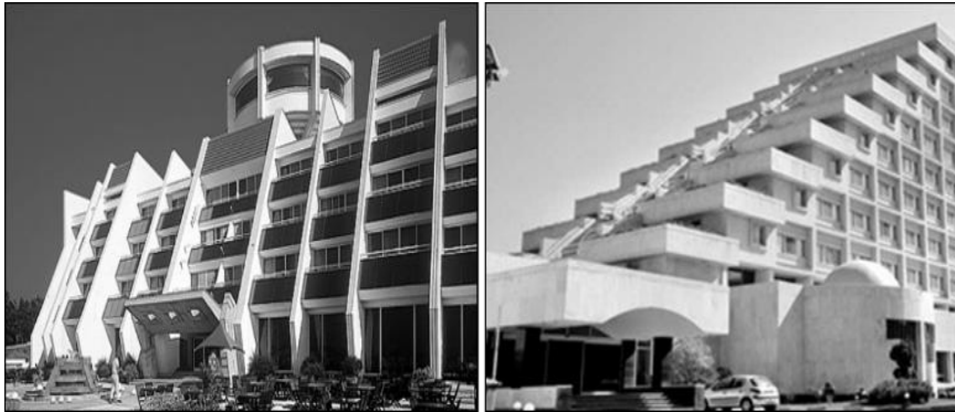
تصویر(۵): فرم مورب یا پلکانی جهت کنترل ریزش آوار (سازمان پدافند غیرعامل کشور، ۱۳۹۲)
