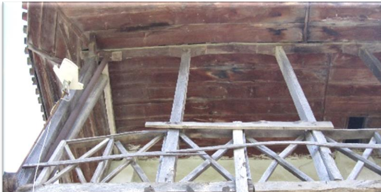
ت. ۷. اجزای سازه‌ای و طرز قرارگیری سقف روی آن (مأخذ: نگارنده)
